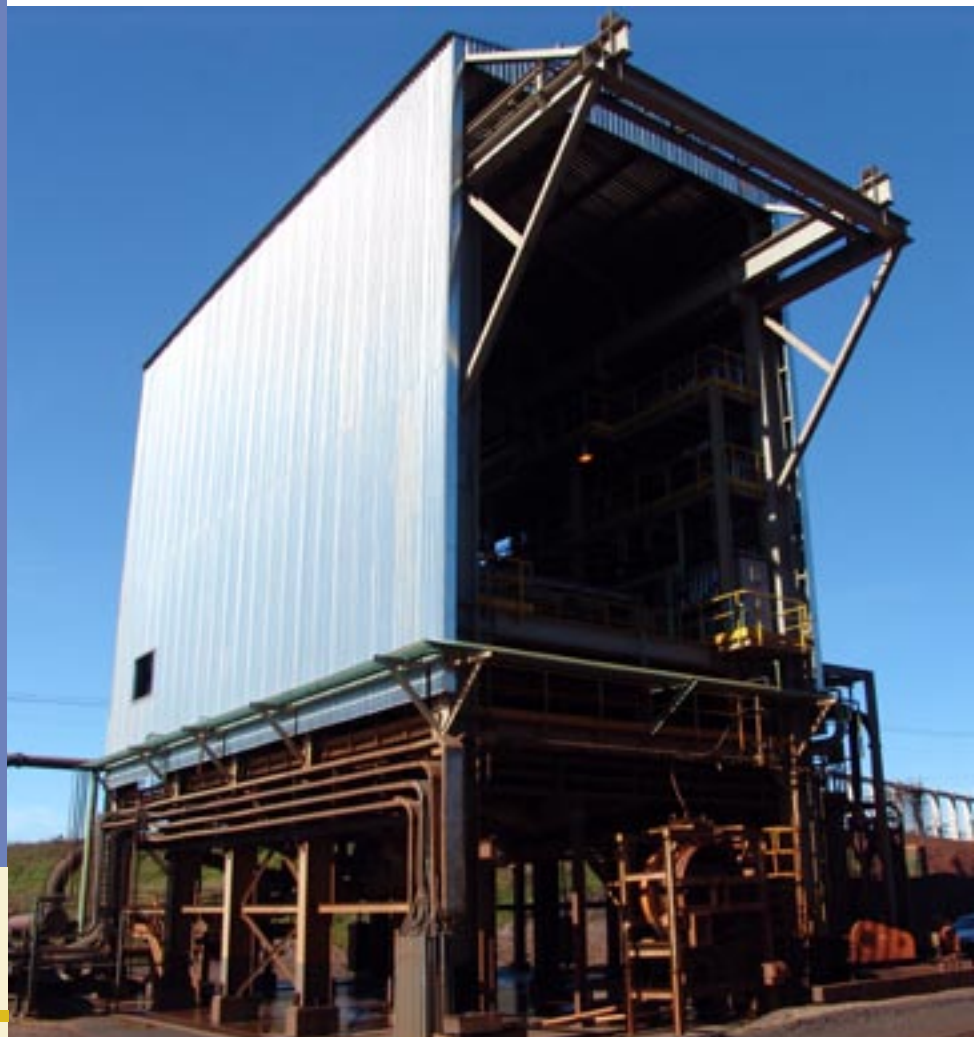
Nova estrutura reaproveita 27% do rejeito da produção
