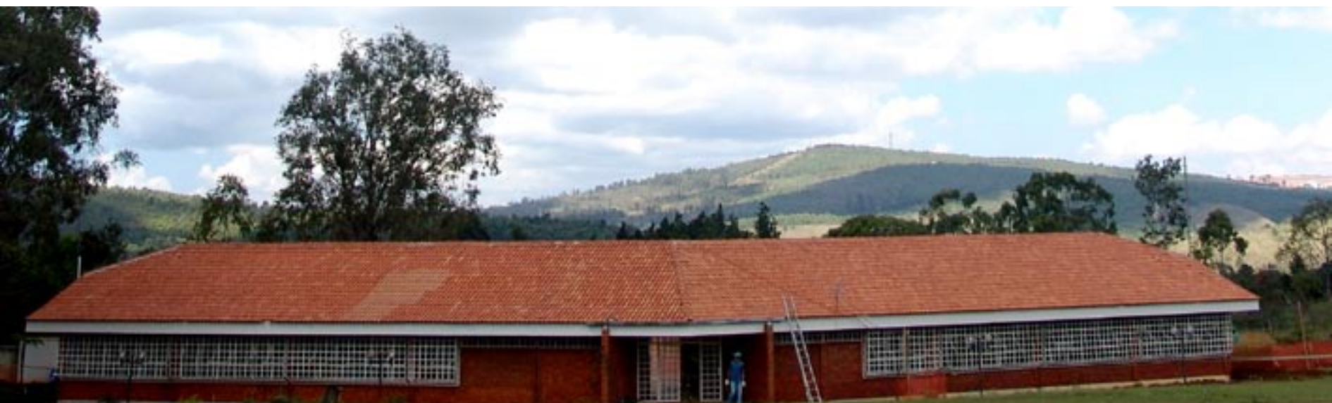
Para abrigar escritórios, foi reformado um prédio e outro está sendo construído, como espelho do já existente
