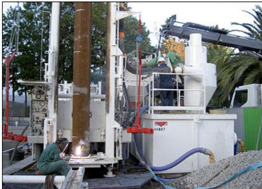
FORAGE POUR GÉOTHERMIE BASSE TEMPÉRATURE (FRANCE)
