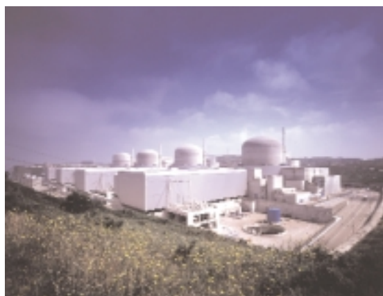
Achevée en 1986, la centrale de Paluel est la tête de série du palier 1300 MWe. La mise en service de la première tranche en 1984 précède largement celle de sa référence américaine South Texas, réalisée par Westinghouse.
