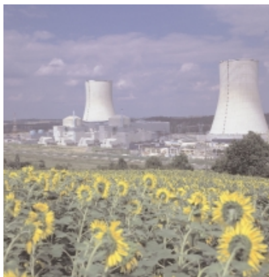
Les deux tranches de la centrale de Civaux représentent le stade le plus avancé de la technologie nucléaire actuelle. Elles constituent également l'étape ultime de la francisation d'une filière initialement développée aux États-Unis.
